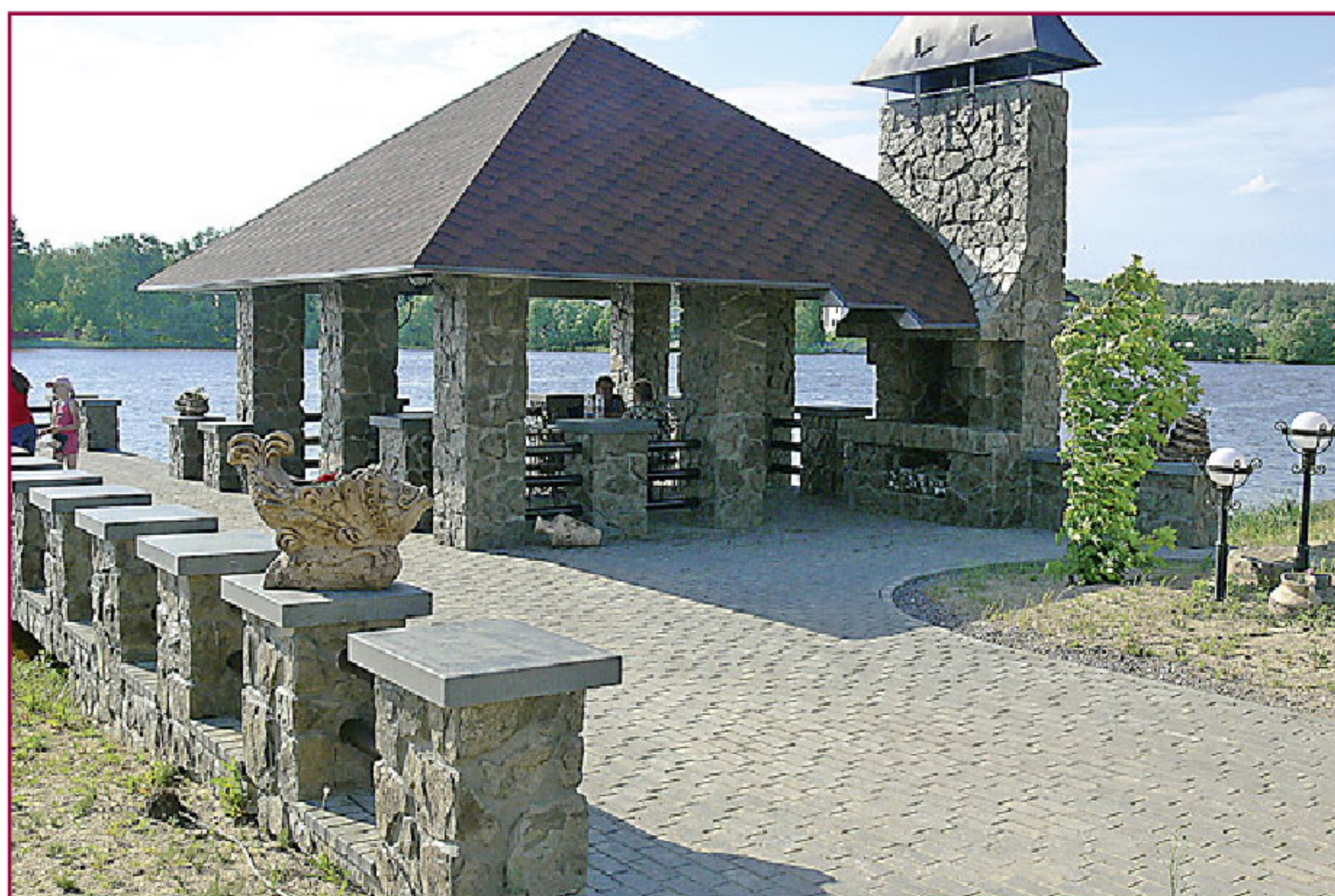
Весь комплекс отделан плитняком. Платформа вымощена тротуарной плиткой.
