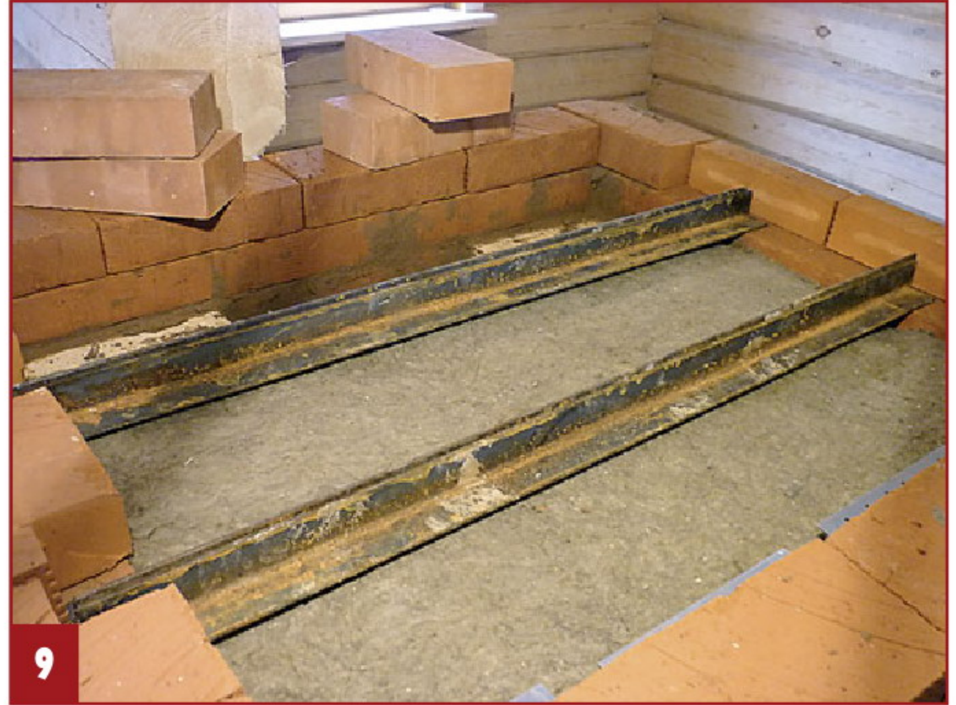
9 Чтобы уголки при тепловом расширении не разрушали кладку, в кирпичах нужно выпилить карманы, которые после установки уголков заполняют утеплителем.
