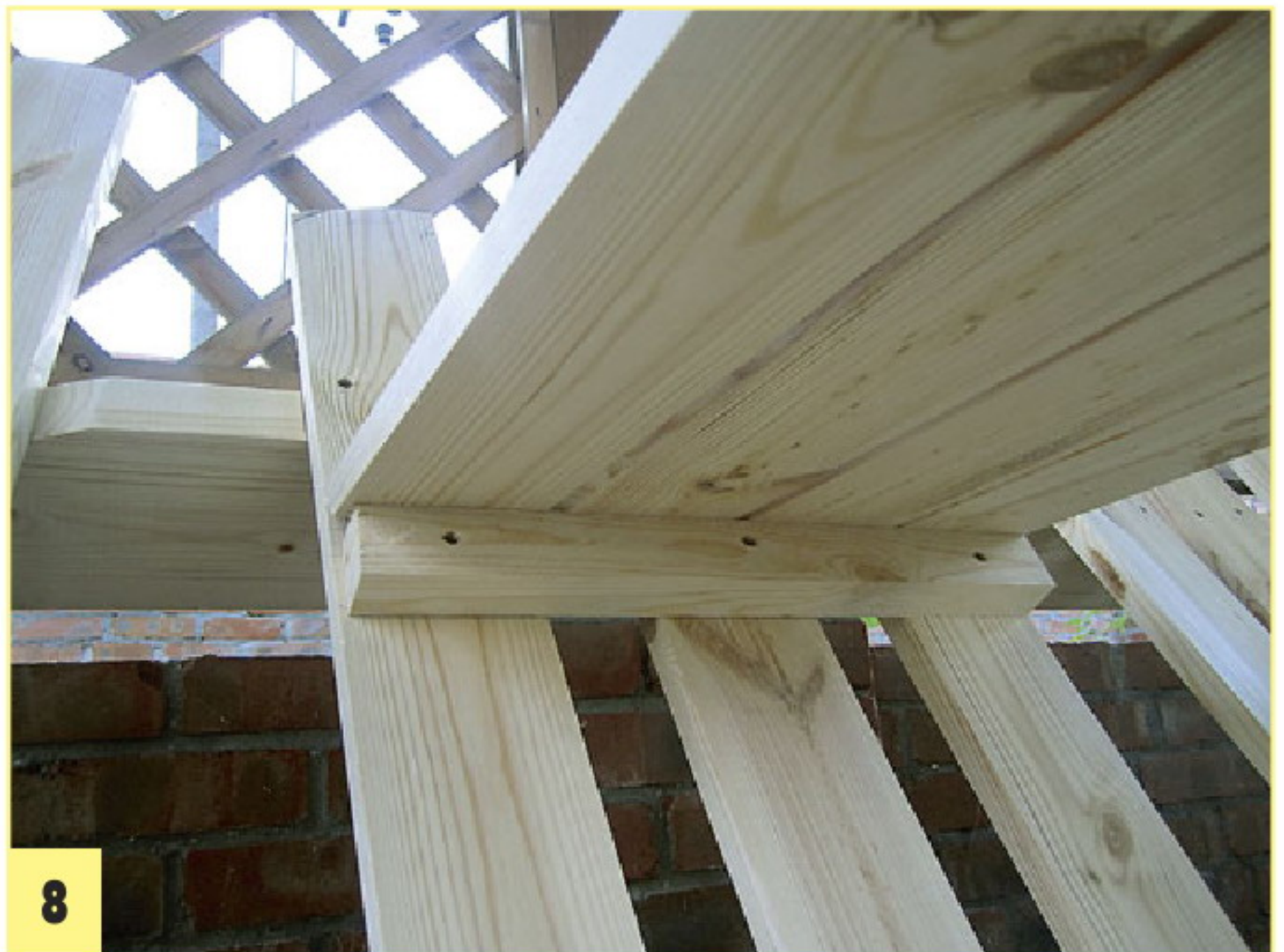
8 К декоративной стенке планки столешницы крепятся с помощью дополнительного бруска.
