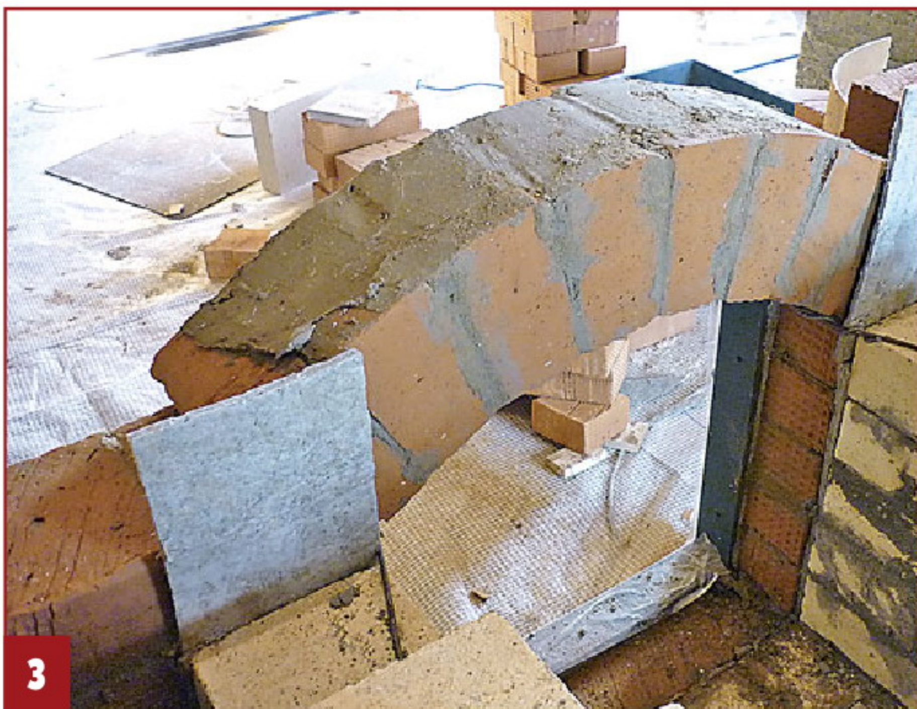
3 Топочное отверстие перекрыто лучковой аркой. Кладка из шамотного кирпича отделена от наружной стены слоем базальтового картона.
