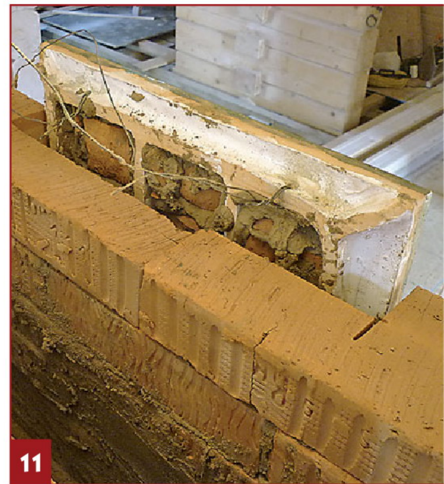
11 Для установки изразца в стенке была сделана небольшая ниша.
