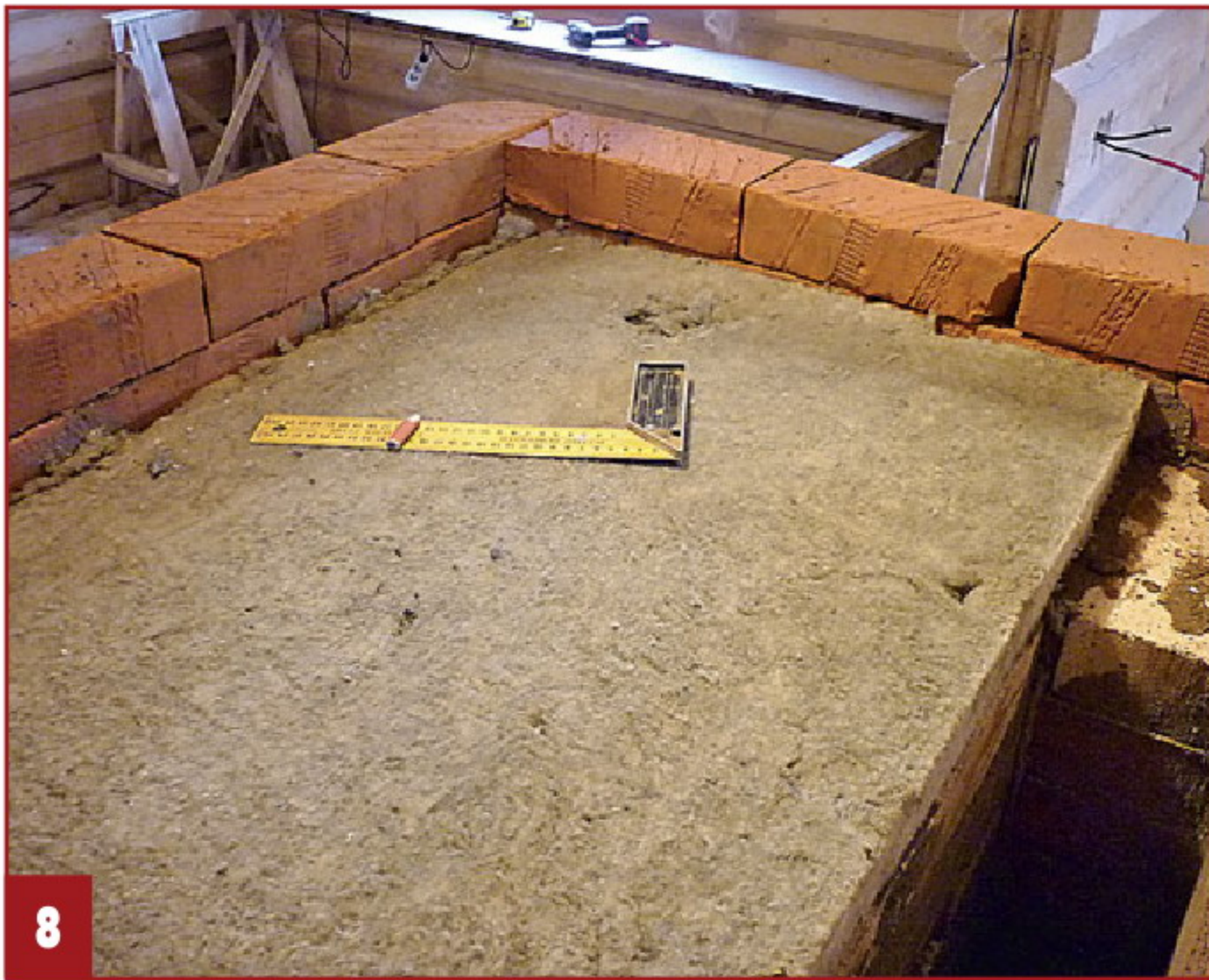
8 На перекрытие топки положен утеплитель, препятствующий перегреву металлических уголков.
