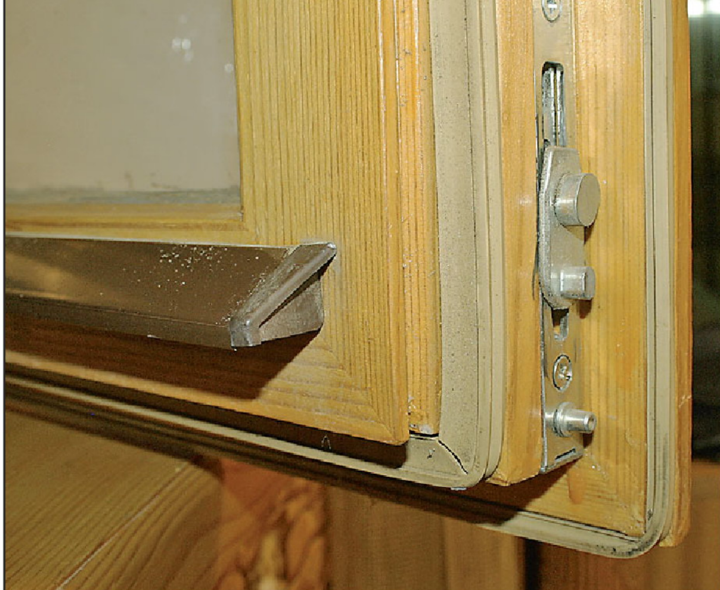
Установленная фурнитура закрывает шпонку в створке, а на торец капельника надевается пластиковая заглушка.
