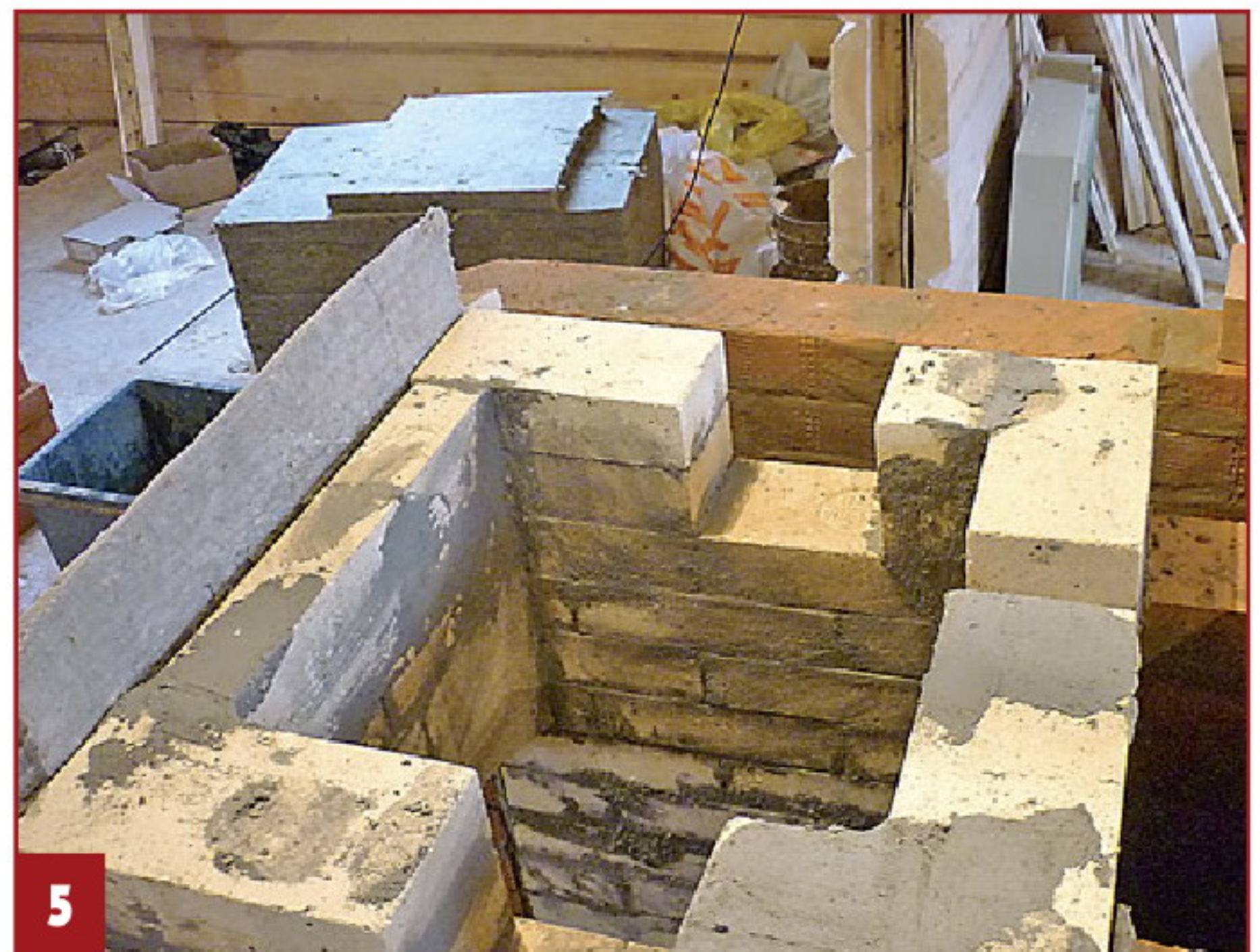
5 На 16-м и 17-м рядах сформированы отверстия для выхода дымовых газов в нисходящие каналы.
