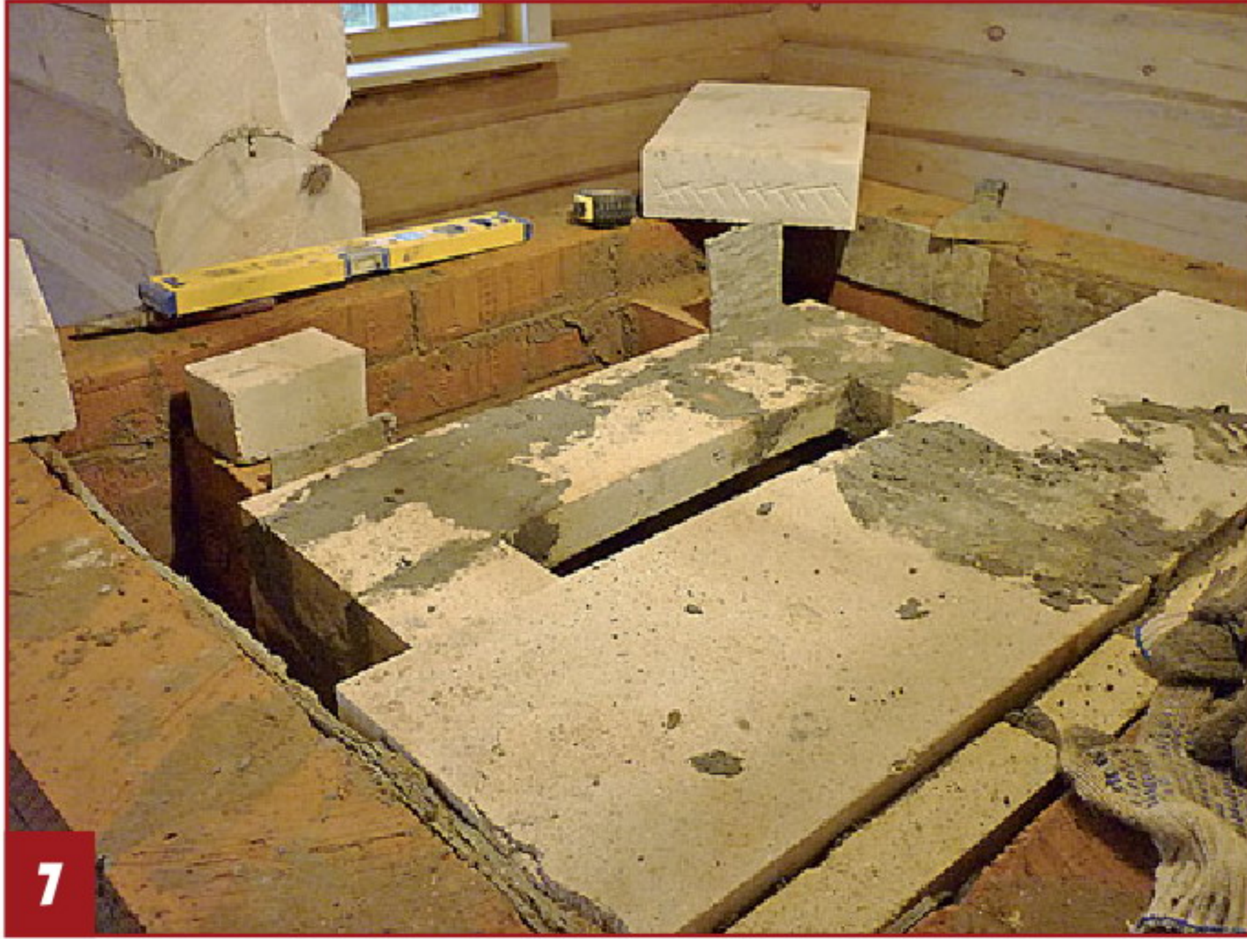
7 Для перекрытия топки использованы шамотные блоки.
