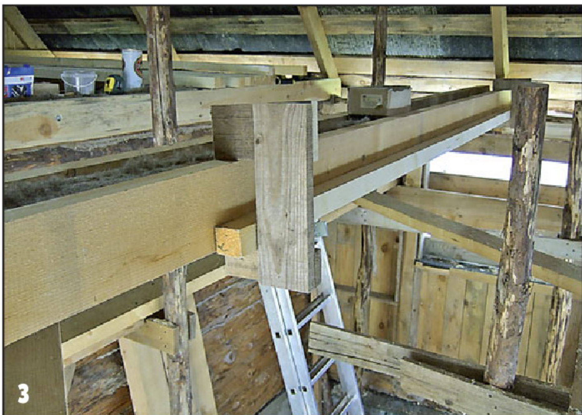
3 У черепных брусков по крайней мере нижняя часть должна быть ровной.
