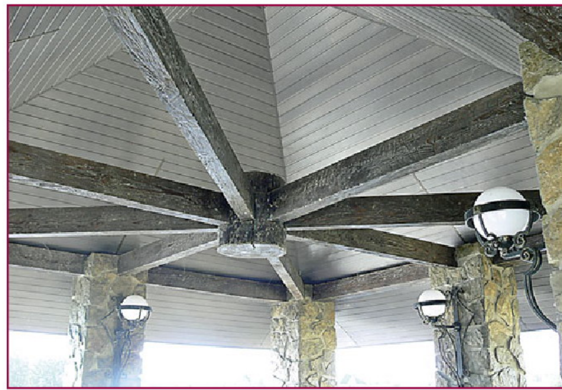
Затяжки каркаса крыши соединены в центре как спицы колеса от телеги в ступице, что смотрится очень эффектно.
