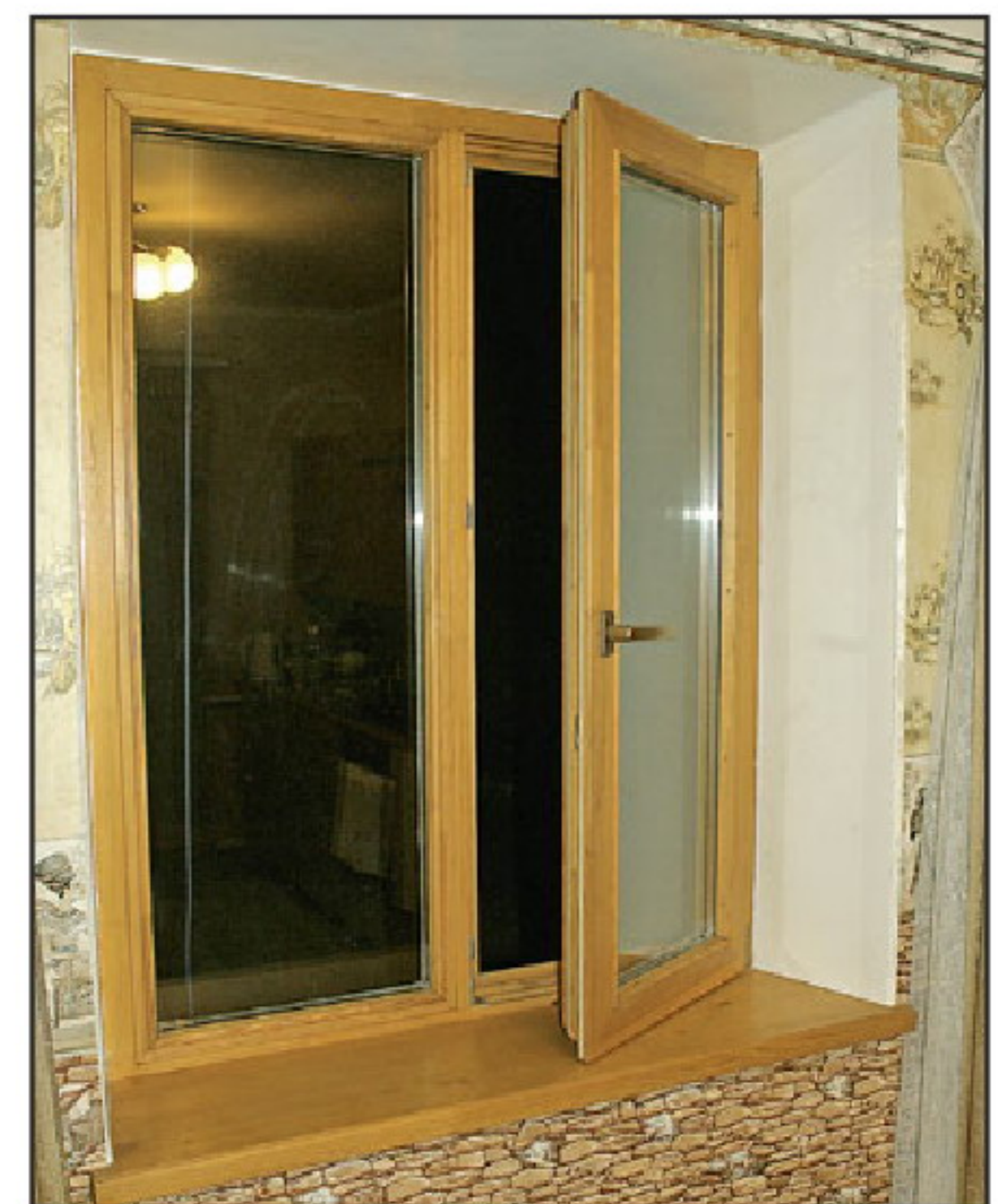
Заготовка для подоконника склеена из остатков бруса 50x80 и 50x100 мм и обработана до толщины 40 мм. Евроокно готово. Благодаря использованию поворотно-откидного механизма створка открывается в двух плоскостях.
