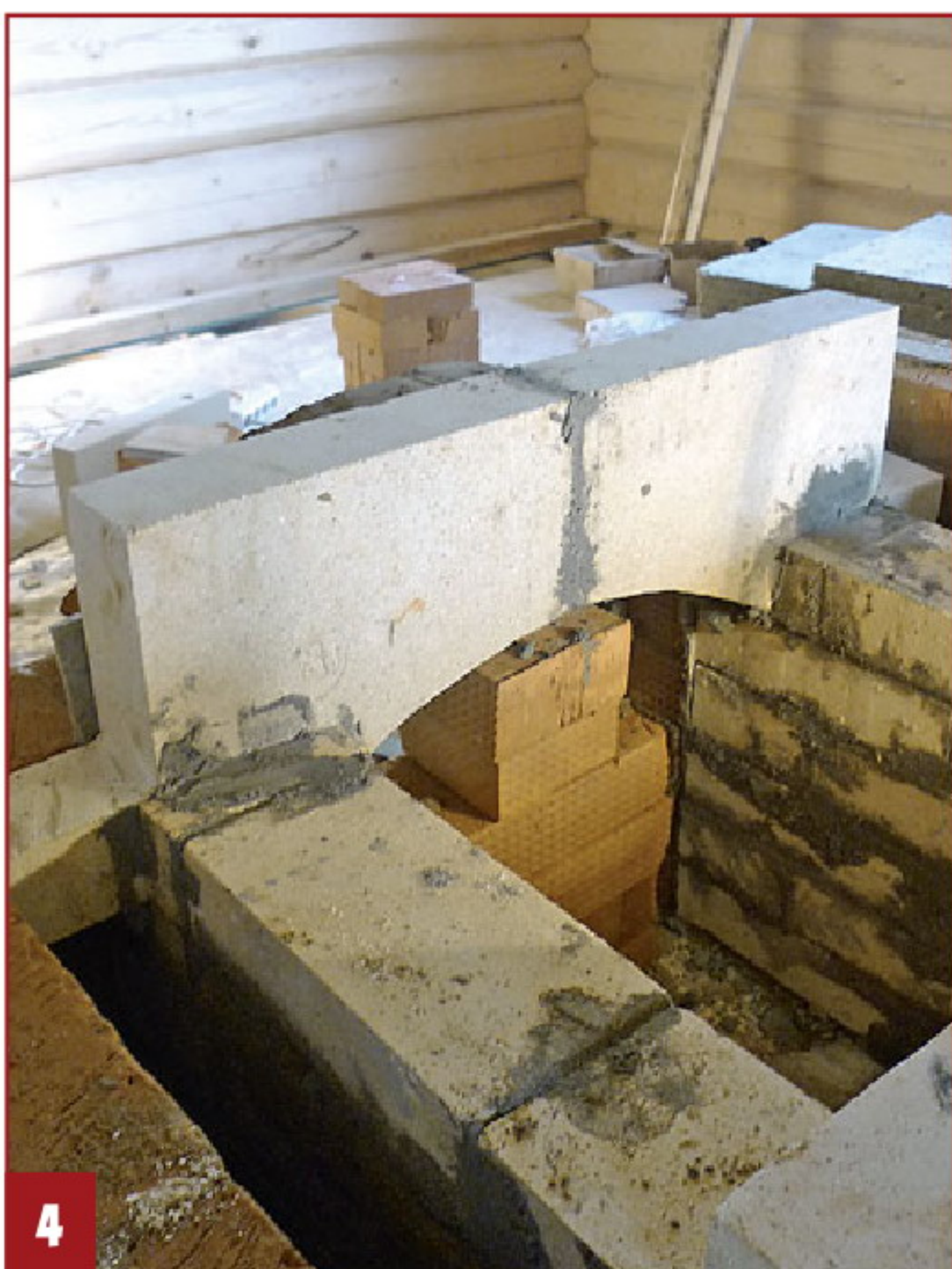
3 Топочное отверстие перекрыто лучковой аркой. Кладка из шамотного кирпича отделена от наружной стены слоем базальтового картона.
